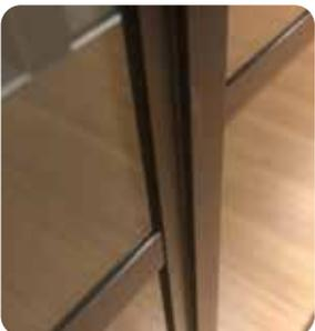
• Separadores mediante barrotillos de 2x20 mm
